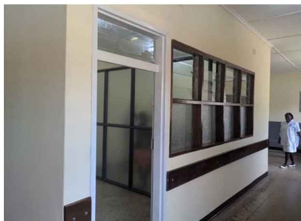
Renovated Diabetes Clinic at Kafue General Hospital
